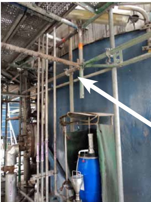
Figure 22 : Décalage de l'implantation des montants
