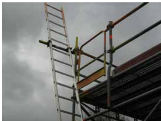
Figure 37 : Accès par une échelle externe et portique
